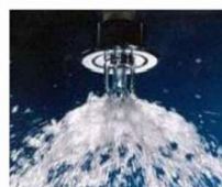
ب: شبکه خاموش کننده مبتنی بر آب (شبکه افشانه‌ای - Sprinkler)، کف، CO 2 ، پودر، ترکیبات هالوژنه
