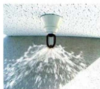
ب: شبکه خاموش کننده مبتنی بر آب (شبکه افشانه‌ای - Sprinkler)، کف، CO 2 ، پودر، ترکیبات هالوژنه
