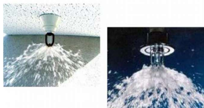
ب: شبکه خاموش کننده مبتنی بر آب (شبکه افشانه‌ای - Sprinkler)، کف، CO 2 ، پودر، ترکیبات هالوژنه
